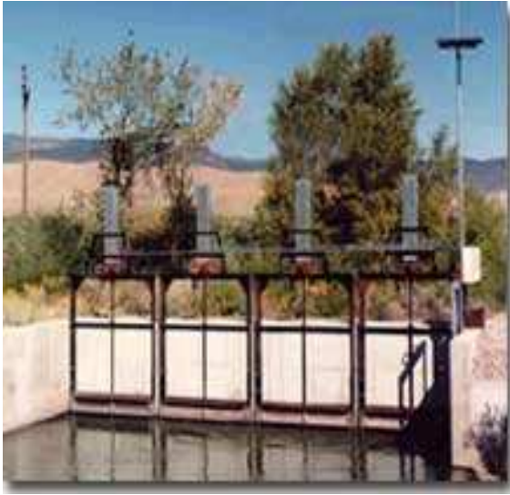
การติดตั้งอุปกรณ์วัดระยะการเปิดบานประตู ระบายน้ำพร้อมกัลลิมิตสวิทช์
