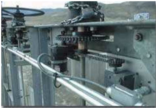
การติดตั้งเกียร์มอเตอร์ DC 12 V. เพื่อควบคุมการ เปิด - ปิดประตูระบายน้ำ
