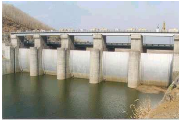
ประตูระบายน้ำคลองส่งน้ำสายใหญ่ซึ่งถูกควบคุมจากศูนย์กลาง
